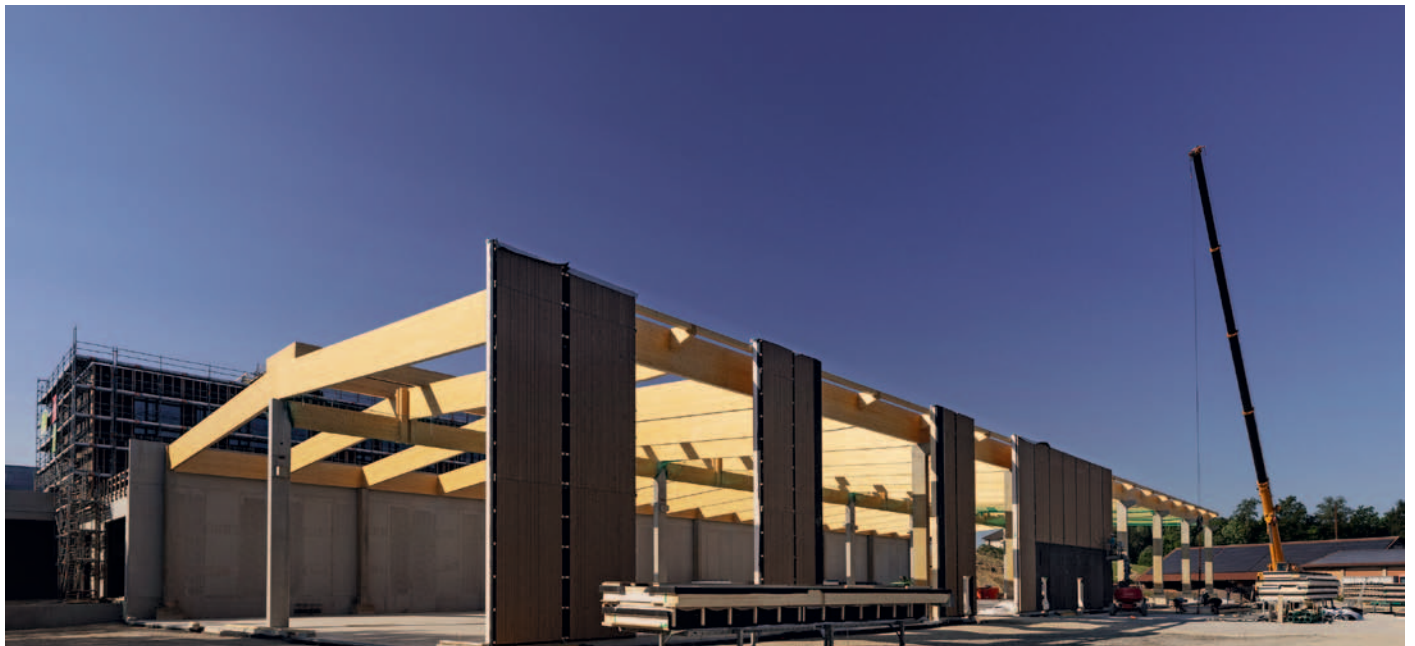
▲ Die neue Halle wurde auf dem Gelände einer alten Ziegelei errichtet
